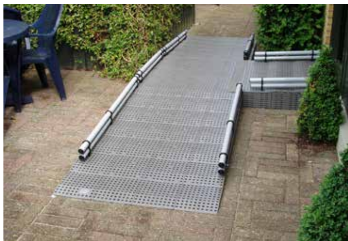
Rampe mit Repos, Neigung 1:14 Für manuelle Rollstühle.
