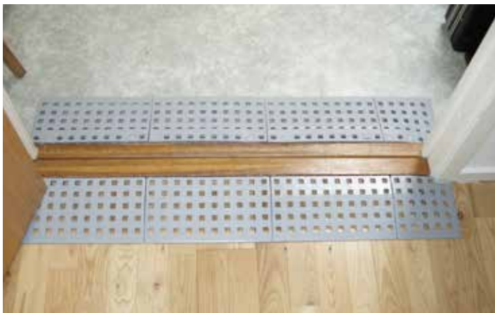
Innenrampe mit Ecken in 1 Schicht.
