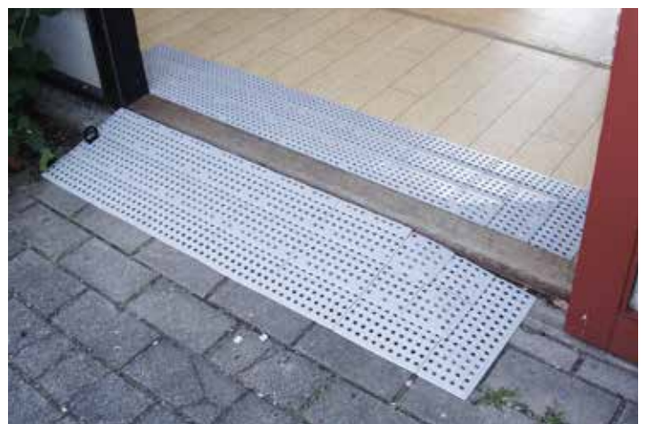
Rampe mit Ecken in 3 Schichten.
