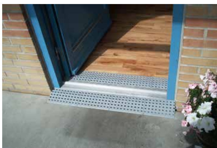
Rampe ohne Ecken in 1 Schicht.
