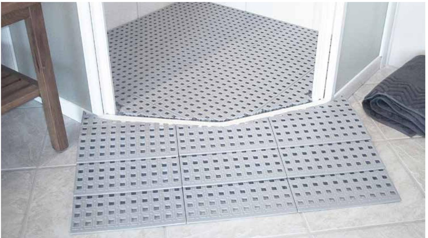
Bei Duschen mit Kante oder Bodenwanne werden Fliesen in die Duschwanne gelegt und eine Rampe installiert.
