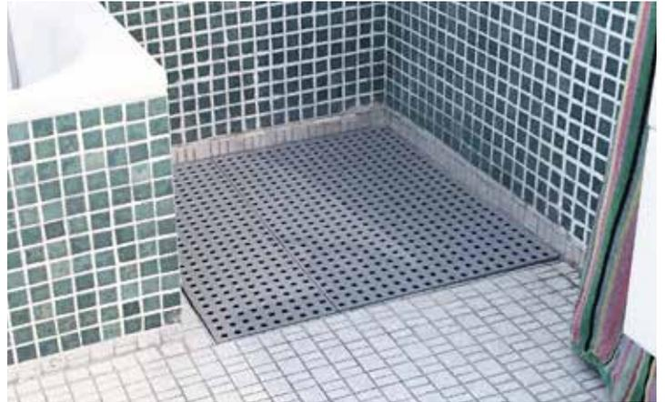
Beispiel einer typischen Duschnische. Eine Duschwanne wie diese wird oft mit Fliesen ausgelegt und falls nötig, wird auch eine kleine Rampe installiert.
